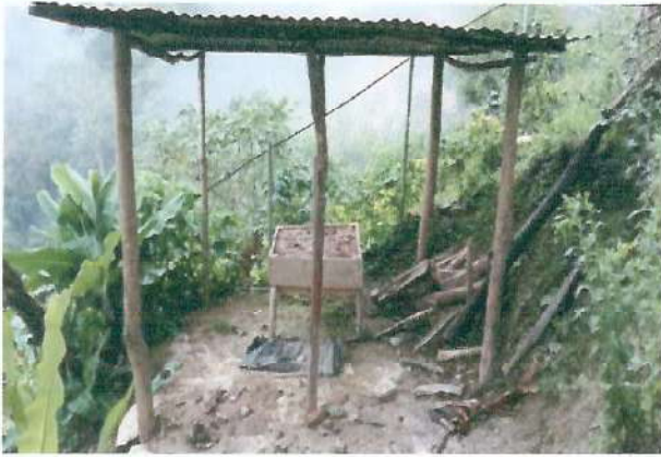
Foto1: MEJORAMIENTO DE COCINA TIPO PORTICO
