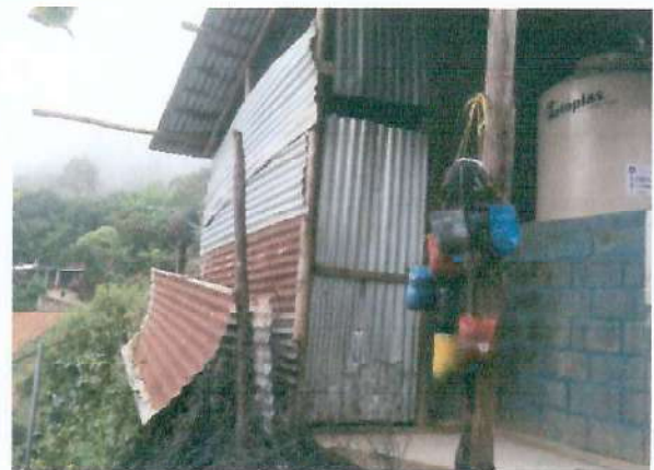
Foto 2: MEJORAMIENTO DE BODEGA PARA ALMACENAMIENTO Y RESGUARDO DE ALIMENTOS Y UTRNCILIOS DE COCINA
